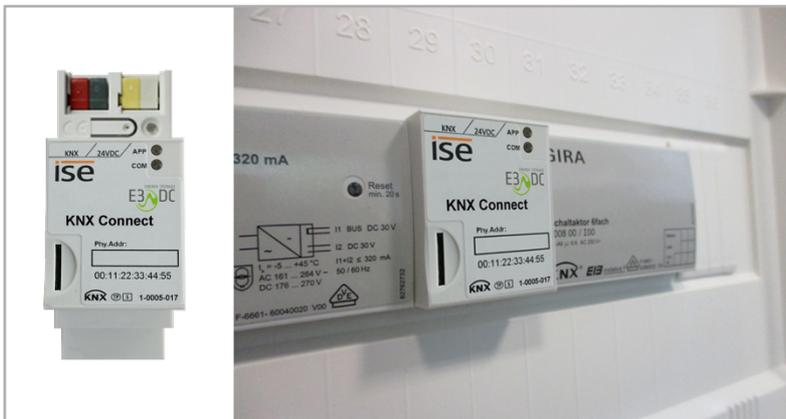
Abb. 1: Verbautes KNX Connect im Installationsverteiler
